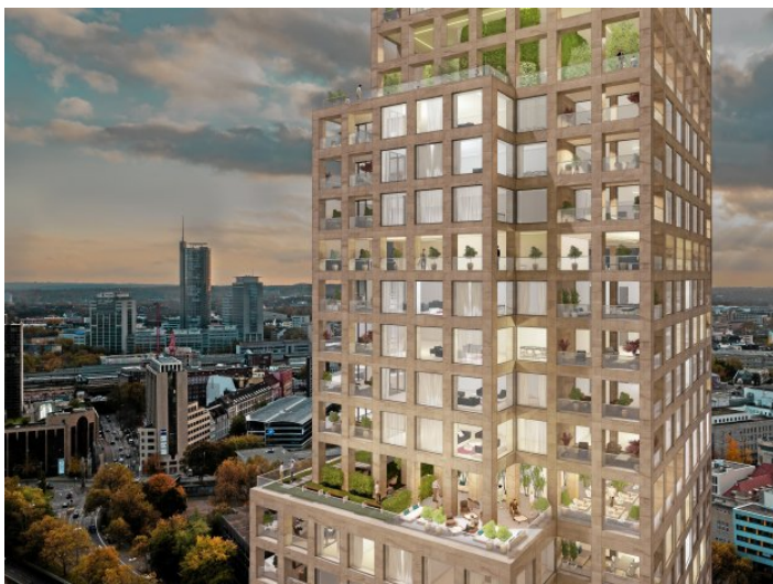
Details der Etagen 19 bis 28 mit den Gärten und Aussichtsplattformen.
